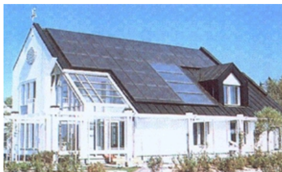
Figura 6.4 – Exemplo de aplicação de painéis solares fotovoltaicos (Fonte: Euro-Sun Technology)
