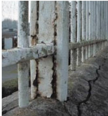
**Corrosión debida a la retención entre partes unidas y no apretadas**
