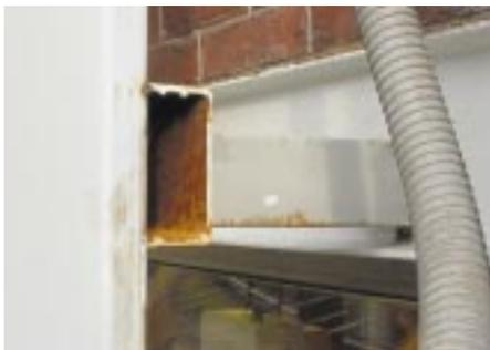
**Corrosión de un cuerpo hueco mal protegido**
