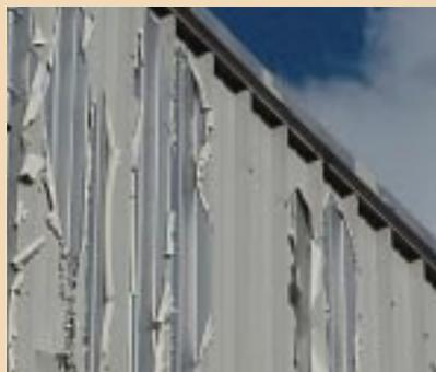
Desprendimiento típico de las películas de pintura depositadas sobre el acero galvanizado.
