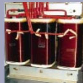
La termografía infrarroja: una prueba simple que permite por ejemplo detectar un calentamiento anormal de una bobina de un transformador debido a un desequilibrio de las cargas.
