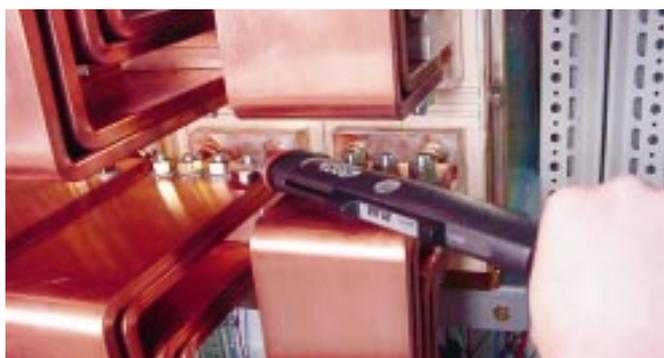
La aplicación de los pares preconizados permite una sujeción óptima de las conexiones.
