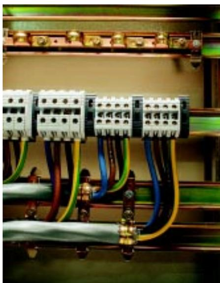
Para una verdadera "cultura de masas": reanudación de blindaje por collarines fijados con "Fixomega" Ref. 36469, (a pedido) perfecta identificación de los circuitos sobre bornes Viking.
