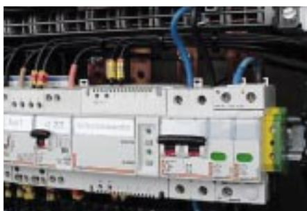
La utilización de un repartidor Lexic permite conectar fácilmente un limitador de sobretensión para la protección de un grupo de circuitos.
