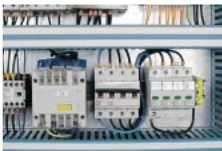
Limitador de sobretensión de alta capacidad (40 kA), a la cabeza de un armario de automatismo industrial: la placa llena de montaje (acero galvanizado) garantiza la conexión equipotencial y la conexión a tierra.
