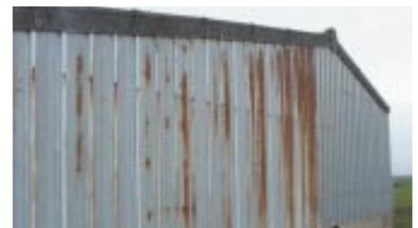
Recubrimiento catódico en final de vida. La capa de zinc (galvanización) se consume completamente en algunas partes, dejando desnudo el metal de base.
