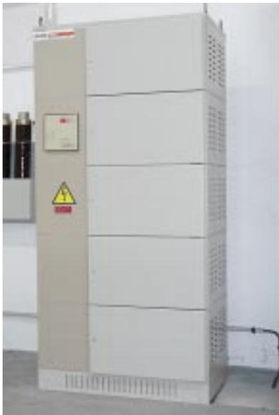
Batería de condensadores en armario, con regulación automática del  $\cos \varphi$
