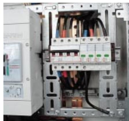
Los elementos de los chasis, montantes y rieles, de los envoltorios XL, poseen una conductibilidad que garantiza la continuidad equipotencial necesaria para la conexión del borne de tierra de los limitador de sobretensión, aquí un modelo de alta capacidad 70 kA.
