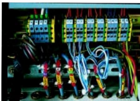
Conexión de los conductores de protección por bornes Viking verde/ amarillo: el riel se utiliza como colector (véase página 134)
