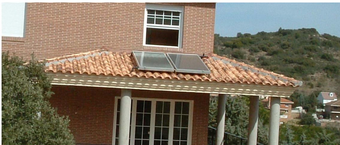
Instalación de captadores mediante superposición arquitectónica.
