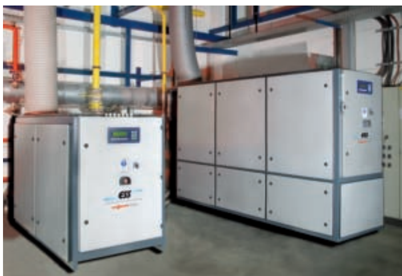
El equipamiento de serie de Vitobloc 200 incluye sincrogenerador y batería de arranque.
