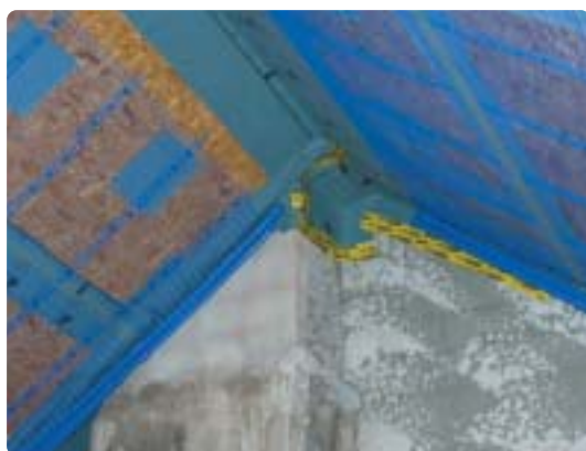
Figura 3.- Uponor malhas capilares cobertura baixa
