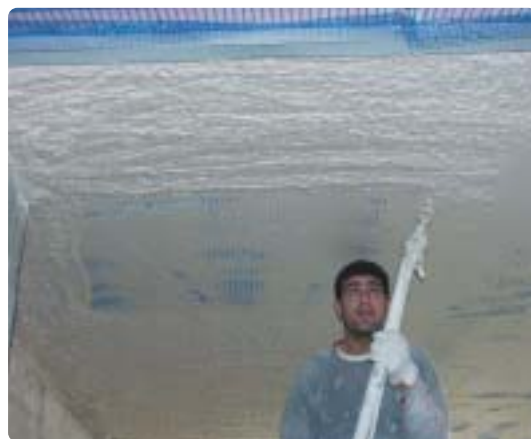
Figura 5.- Projecção de estuque de gesso sobre as malhas capilares.
