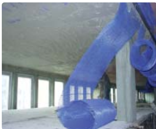
Figura 2.- Fixação, com guias, das malhas capilares ao tecto.
