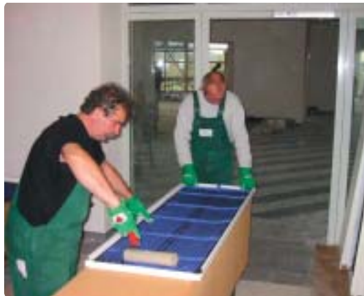
Figura 1.- Colagem da malha capilar sobre um módulo de tecto falso metálico.
