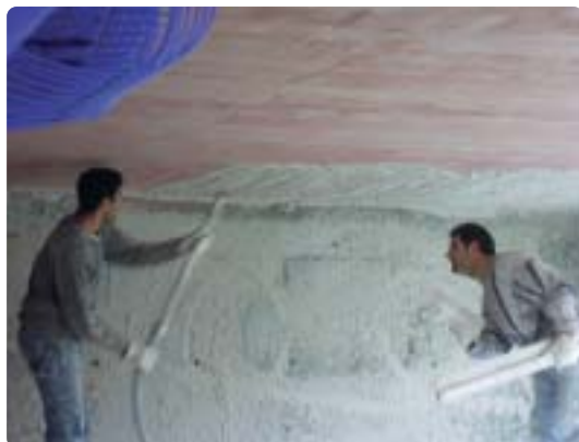
Figura 3.- Projecção da primeira camada de gesso sobre o tecto.
