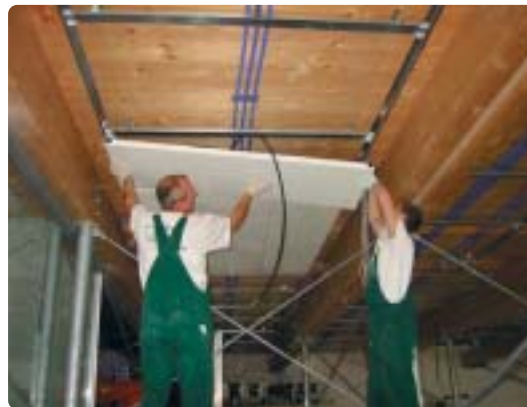
Figura 4.- Montagem dos módulos do tecto falso.
