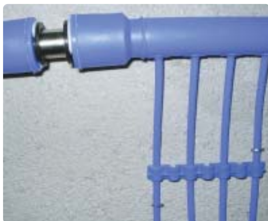
Figura 2.- Fixação, por meio de agrafes, das malhas capilares ao tecto.
