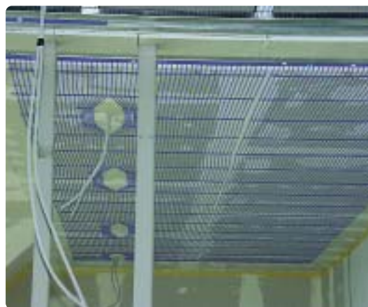
Figura 4.- Cavidades para a saída de cabos eléctricos.
