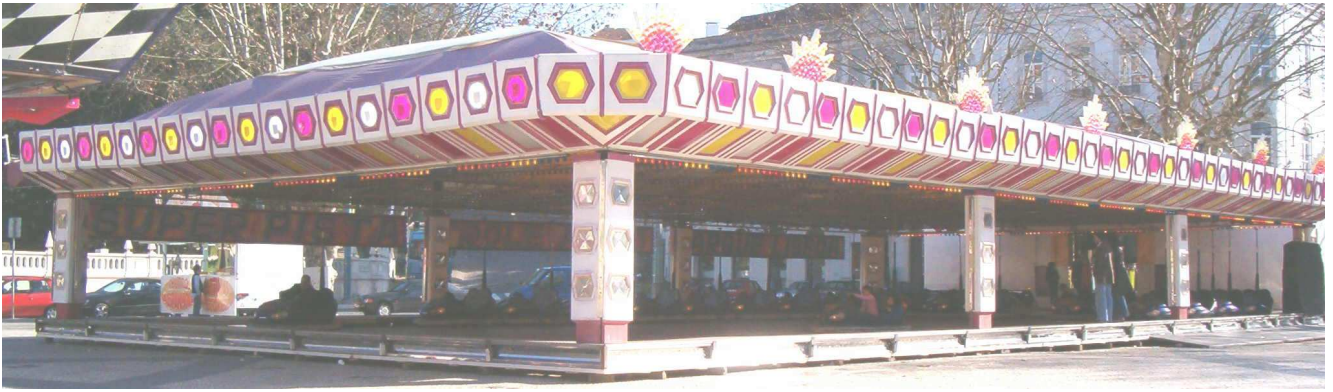
Armadura inox p/ topos de tapa-colunas e painéis luminosos decorativos de 6m, Coimbra, Praça da Rep.
