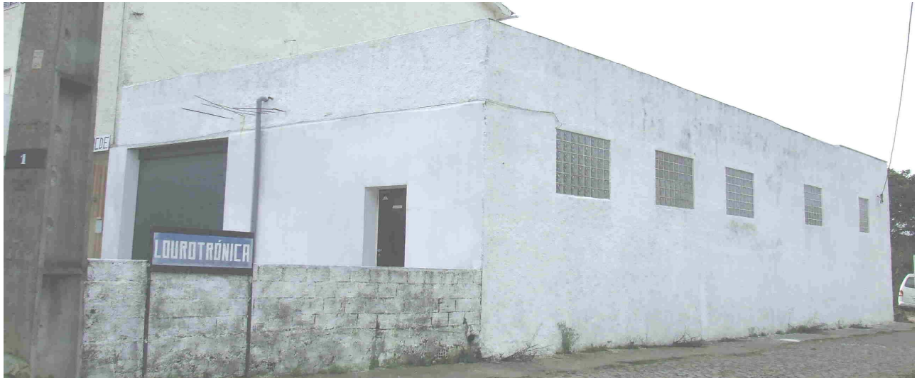
Edifício da Lourotronica com abastecimento eléctrico ao fundo
